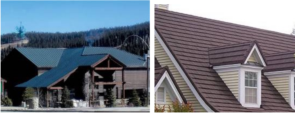
Fotografias 199 e 200 – Exemplos de residências com telhas produzidas a partir do galvalume.
