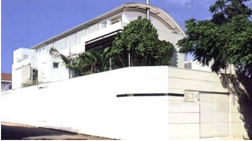
Fotografia 34 – Residência com cobertura com estrutura treliçada em aço.
