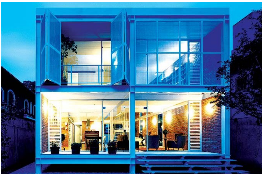
Fotografia 45 – Residência com chapa perfurada compondo esquadria na fachada.
