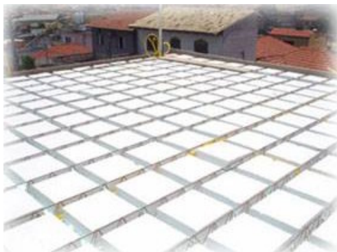
Fotografia 111- Exemplo de laje treliçada bidirecional.
