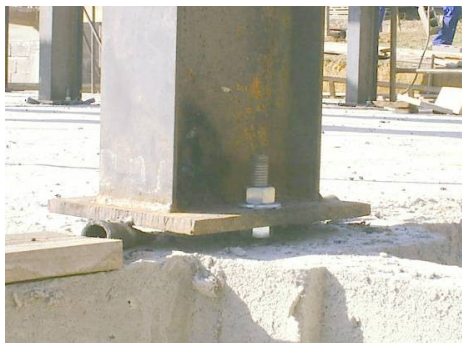
Fotografia 101 - Exemplo de pilar em perfil I lançado sobre fundação em concreto armado. O nivelamento é ajustado através do parafusamento na base do pilar, que é feita com uma chapa grossa com os furos bitolados que se encaixam nos chumbadores fixados no cintamento de concreto armado.
