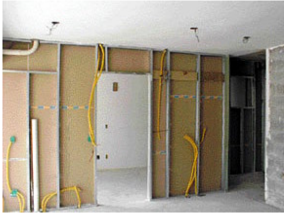
Fotografia 14- Exemplo de montagem de uma parede do sistema construtivo Dry wall .
