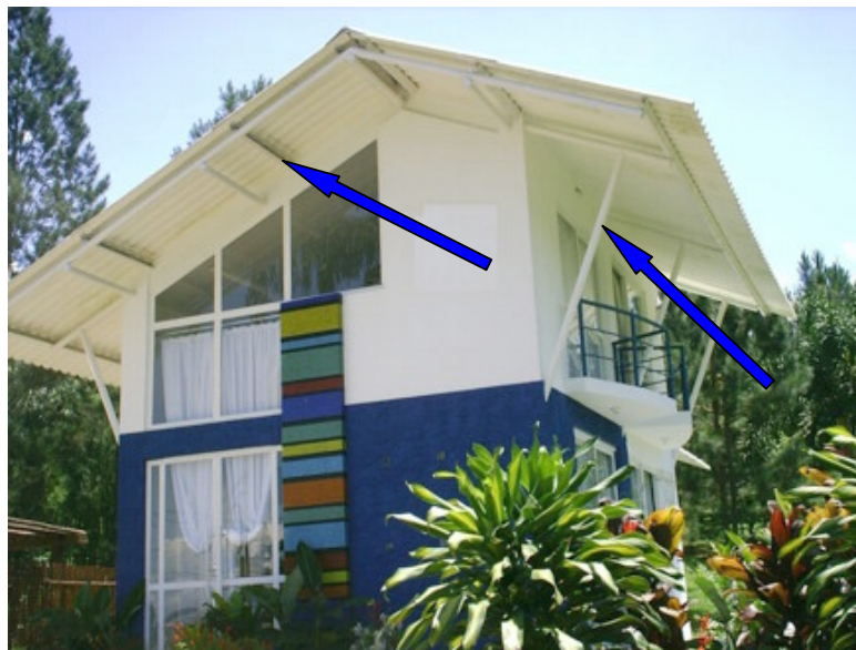
Fotografia 24- Perfil tubular redondo em estrutura do telhado e guarda corpo. Perfil tubular retangular em esquadrias.
