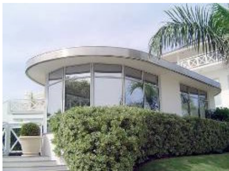
Fotografia 196– Exemplo de uso aço inox em platibanda.
