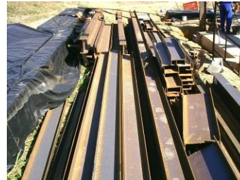
Fotografia 10 - Perfis laminados da Gerdau a serem utilizados em obra em Penedo.
