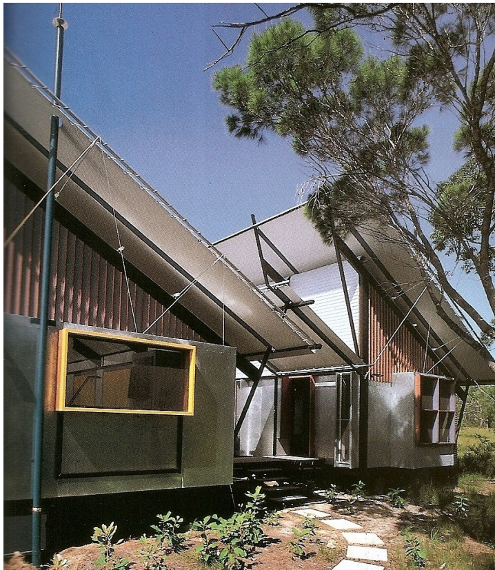
Fotografia 183 – Exemplo de residência com cobertura em membrana tensionada. Local: Noosa Heads, Austrália.
