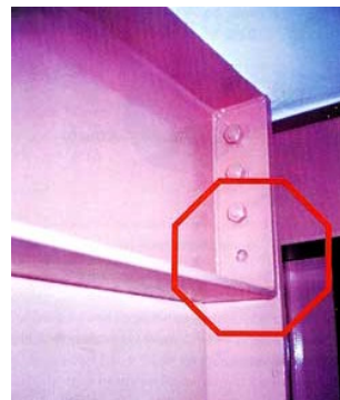
Fotografia 98 - Falha em ligação parafusada.
