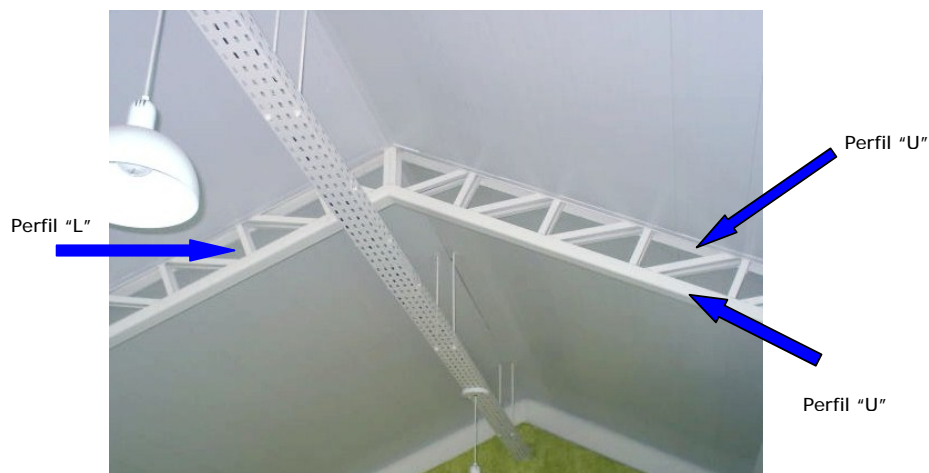
Fotografia 17- Exemplo de utilização de perfil “U” e “L” em treliça de sustentação de telhado.
