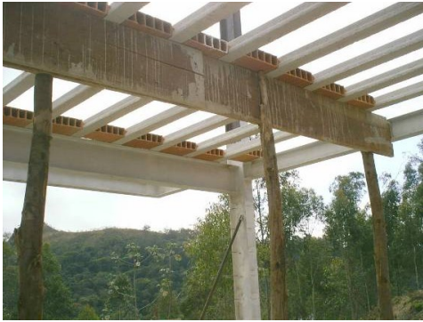
Fotografia 108 - Início da colocação de laje pré-moldada comum em obra residencial. A estrutura metálica já está protegida com "primer".
