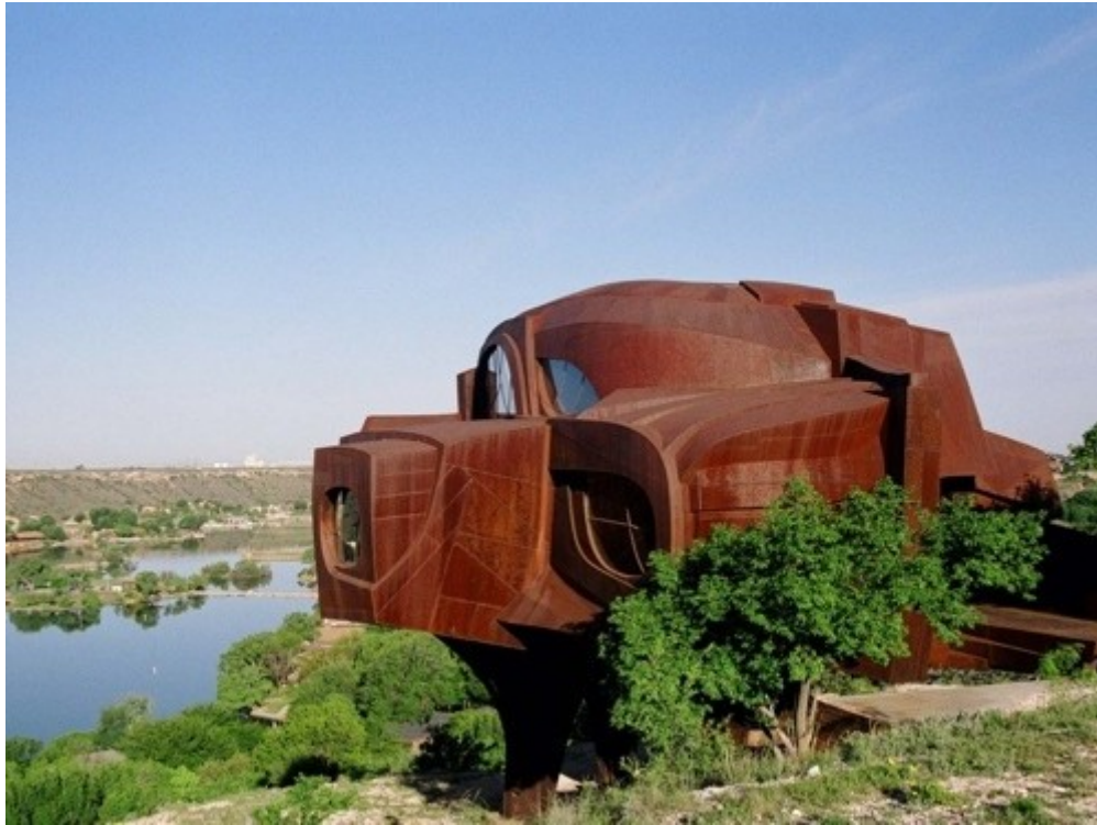
Fotografia 67 - Rusted Steel House , EUA.
