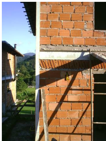
Fotografia 124 - Alvenaria já encunhada.
