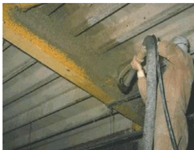
Fotografia 205 - Argamassa projetada, constituída basicamente de gesso (aproximadamente 80% do peso seco), cimento Portland (em materiais de média e alta densidade), resinas acrílicas e cargas inertes, tais como poliestireno expandido, celulose e preservantes.
