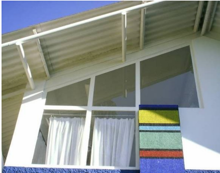
Fotografia 25- Perfil tubular redondo em estrutura do telhado. Perfil tubular retangular em esquadrias.
