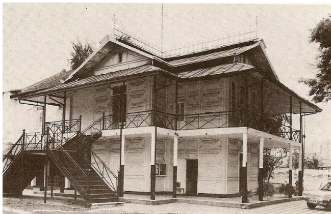
Fotografia 5 - Chalé de ferro da UFPA (Universidade Federal do Pará), com sistema construtivo Danly (sistema de vedação com chapas de aço estampadas e galvanizadas), em Belém, PA. Exemplo de residência importada nos fins da década de 1880, provavelmente da Bélgica.
