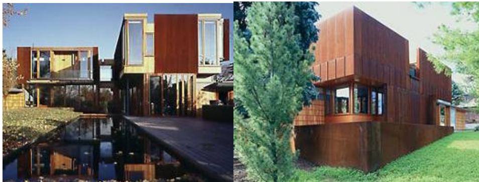
Fotografia 191 – Exemplo de residência em chapas de aço patinável aparentes.
