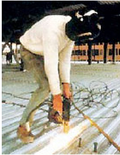
Fotografia 39 – Instalação de stud bolts .
