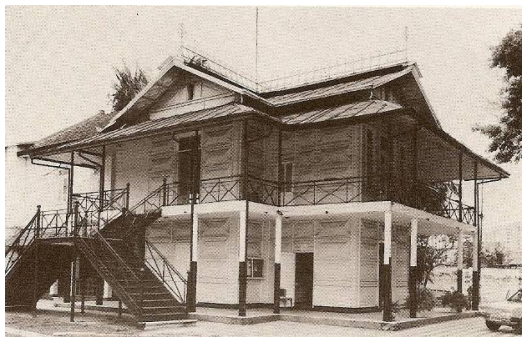
Fotografia 130 - Chalé de ferro da UFPA (Universidade Federal do Pará), com sistema construtivo Danly (sistema de vedação com chapas de aço estampadas e galvanizadas), em Belém, PA.
