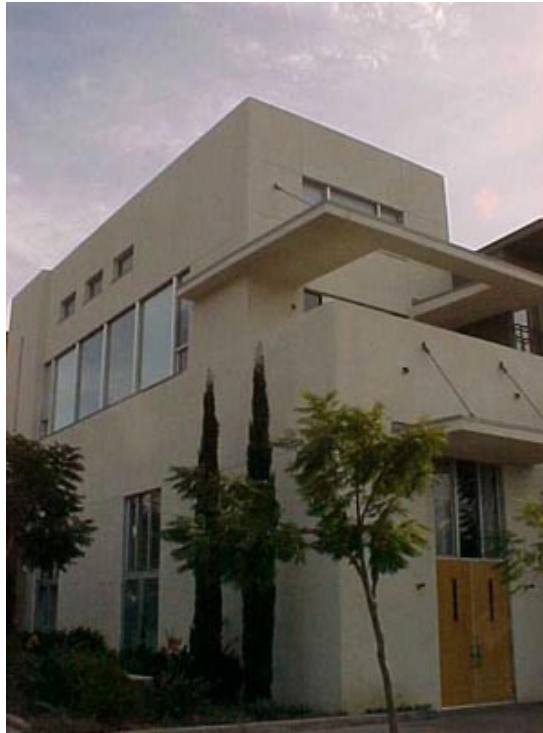
Fotografia 143 – Exemplo de residência, nos Estados Unidos, com painel GFRC e estrutura em aço leve, dobrado a frio.
