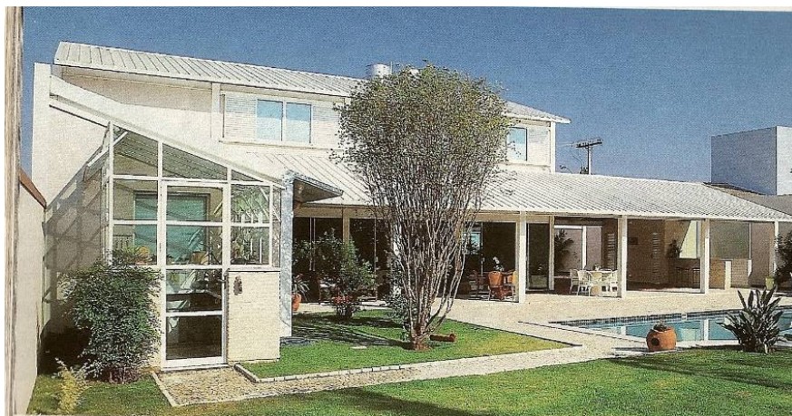
Fotografia 178– Exemplo de residência com cobertura em aço em telhas zipadas, em Uberlândia, MG.
