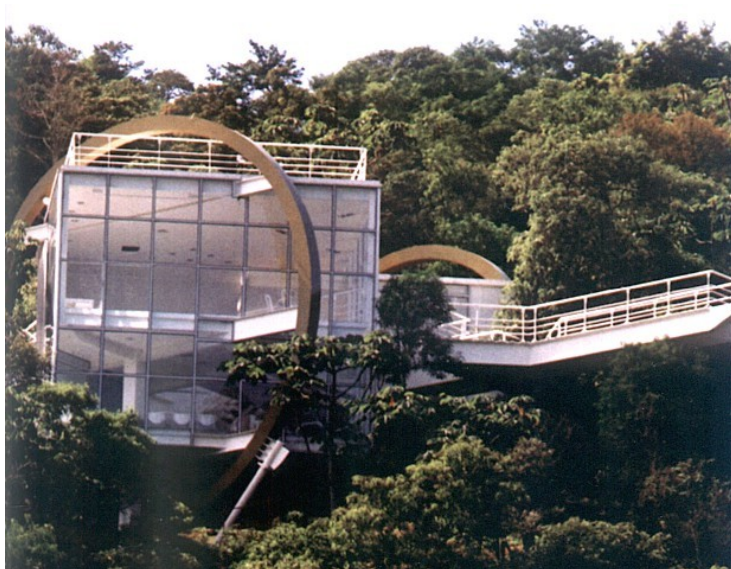
Fotografia 78- Residência na Serra da Cantareira, SP.
