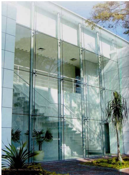
Fotografia 162 – Exemplo de edificação com o sistema Spider Glass .
