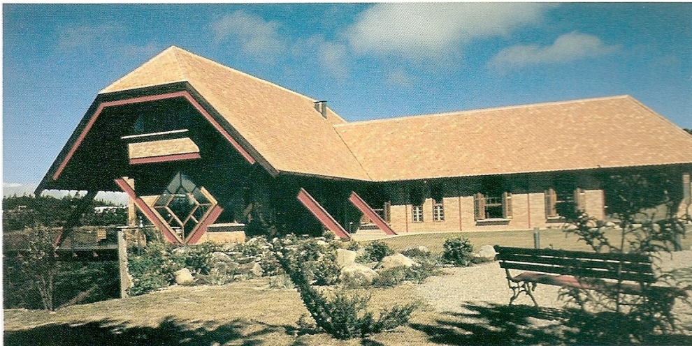
Fotografia 172 - Exemplo de cobertura estruturada em perfis de aço com telhas cerâmicas. Local: Campos do Jordão, SP.
