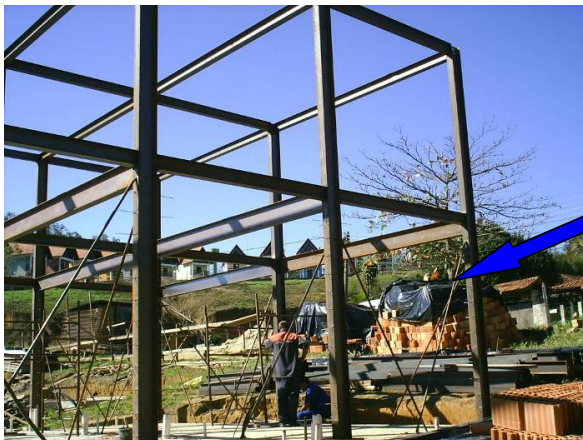
Fotografia 94 - Contraventamento temporário, para auxílio de prumo dos pilares durante a execução da estrutura soldada de obra residencial realizada com perfis laminados.
