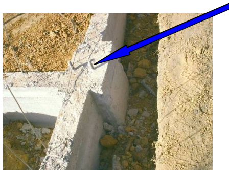
Fotografia 100 -Exemplo de fundação já concretada, com os chumbadores de aço, que são rosqueados como parafusos, preparados para receberem os pilares em aço.
