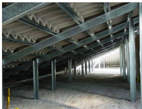
Fotografias 174 e 175 - Exemplo de utilização de aço leve galvanizado na estrutura da cobertura de uma residência.
