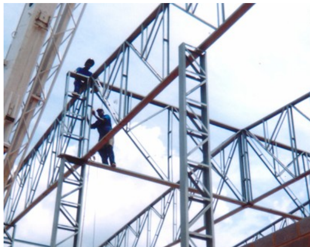
Fotografia 16- Composição de pilares e vigas treliçadas com cantoneiras em “L” e perfis “U”.
