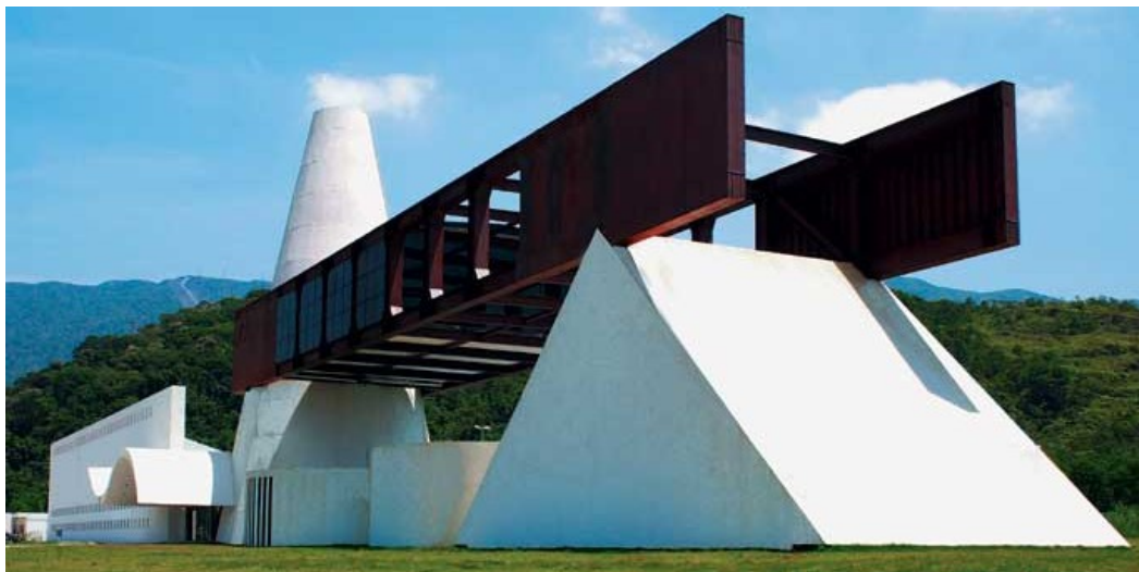
Fotografia 38 – Exemplo de viga em quadro na obra do Centro de Capacitação e Pesquisa do Meio Ambiente.
