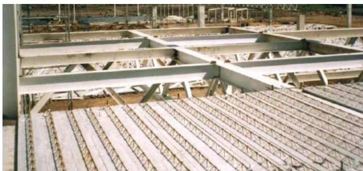
Fotografia 110 - Exemplo de laje treliçada unidirecional. Este tipo de laje unidirecional é mais comum do que a bidirecional em residências.
