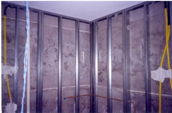
Fotografia 145 – Exemplo de aplicação de placa cimentícia.
