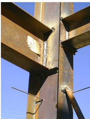
Fotografia 120 - Ferro-cabelo liso uni-direcionado , soldado à estrutura. Estes já foram sendo soldados logo após a execução da estrutura metálica.
