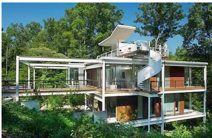
Fotografia 63 -Exemplo residência cuja concepção estrutural está exposta na arquitetura.
