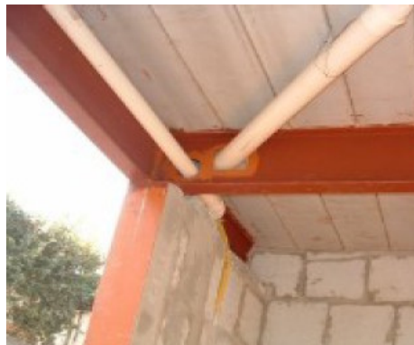
Fotografia 106- Viga furada para passagem de dutos. Observe que a pintura de proteção foi refeita no local recortado.
