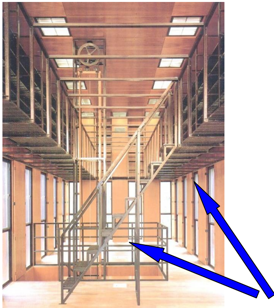
Fotografia 48– Piso em grade metálica, em mezanino que é utilizado como biblioteca no interior da “T house”.
