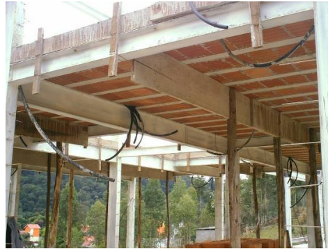
Fotografia 109 - Laje pré-moldada de concreto em obra residencial. Observar escoramento em madeira, necessário em função do vão.
