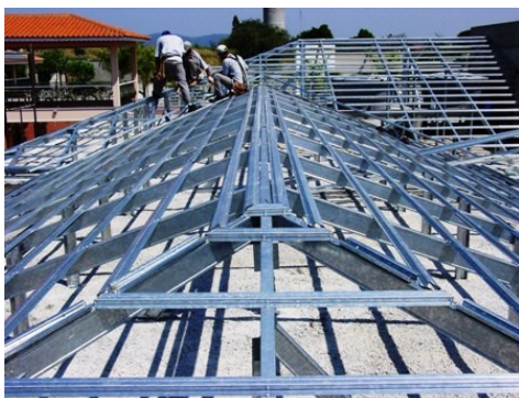
Fotografias 174 e 175 - Exemplo de utilização de aço leve galvanizado na estrutura da cobertura de uma residência.
