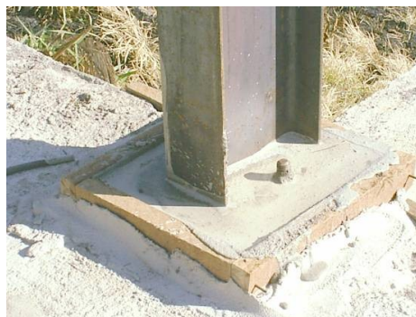
Fotografia 102 - Exemplo de nivelamento de base de pilar, finalizado e enrijecido com a execução de uma pequena base com graute.
