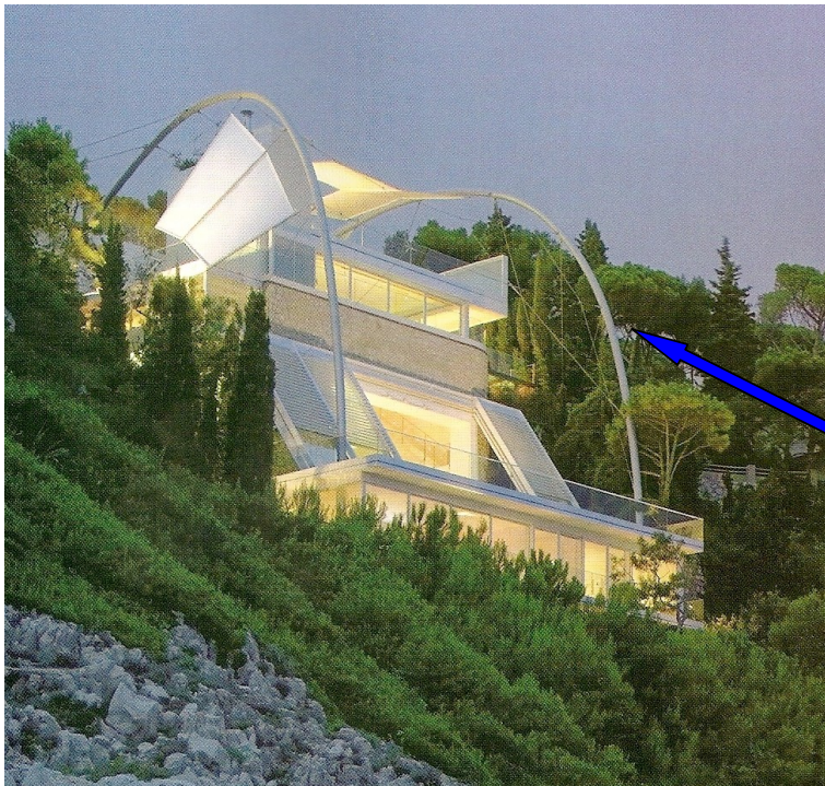
Fotografia 26- Residência com estrutura tubular redonda formando arcos que suportam uma cobertura de membrana tensionada.
