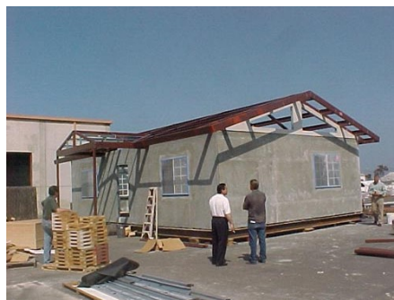
Fotografia 142- Exemplo de execução de residência, nos Estados Unidos, com painel GFRC e estrutura em aço leve, dobrado a frio .
