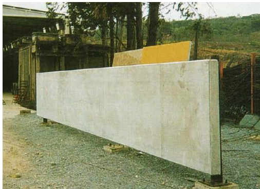
Fotografia 132 - Exemplo de painel de concreto, com acabamento liso.
