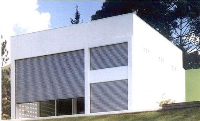
Fotografia 155 – “Casa em Petrópolis”. Local: Petrópolis, RJ, Brasil.
