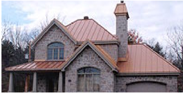
Fotografia 179– Exemplo de residência com cobertura em aço em telhas zipadas, no Canadá.
