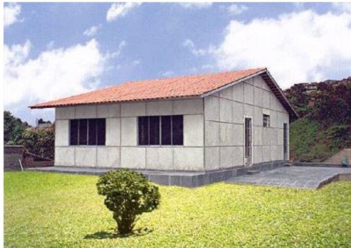
Fotografia 146 – Exemplo de residência com vedação externa em painéis com placas cimentícias.
