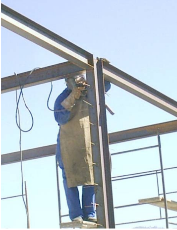
Fotografia 91 - Soldador trabalhando obra residencial realizada com perfis laminados.
