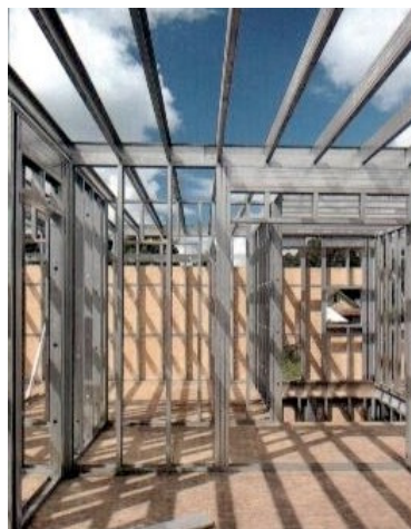
Fotografia 13 - Ossatura de uma residência feita com sistema construtivo Light Steel Frame . Projeto: Luciano Setim Freitas. Local: Curitiba, PR.
