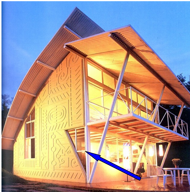
Fotografia 23- Residência com pilar em perfil tubular redondo em pilares, estrutura do telhado e guarda corpo.
