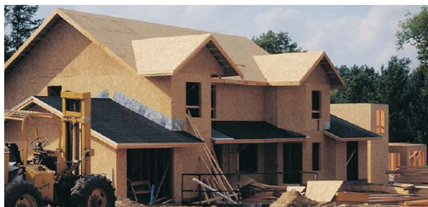
Fotografia 164 - Exemplo de utilização de painel "OSB" em residência.
