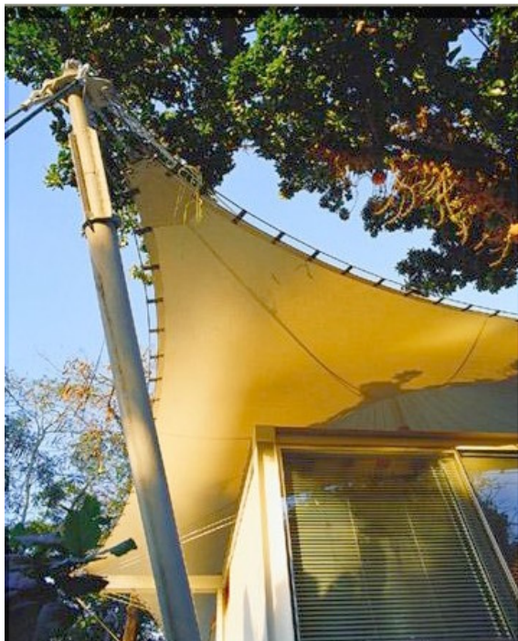
Fotografia 184 - Residência Itanhagá. Local: Brasil.
