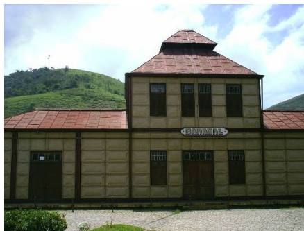
Fotografia 131 – Estação ferroviária de Bananal, SP, com sistema construtivo Danly. Sistema de vedação com chapas de aço estampadas e galvanizadas.
