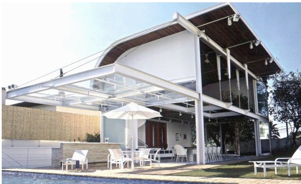
Fotografia 85 - Pavilhão Freiberg. Local: São Paulo, SP.
