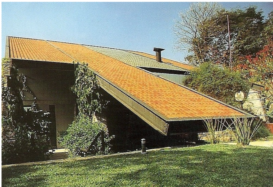
Fotografia 173 - Exemplo de cobertura estruturada em perfis de aço com telhas cerâmicas. Local: São Paulo, SP, Brasil.
