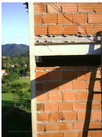
Fotografia 123 - Alvenaria esperando para ser encunhada.
