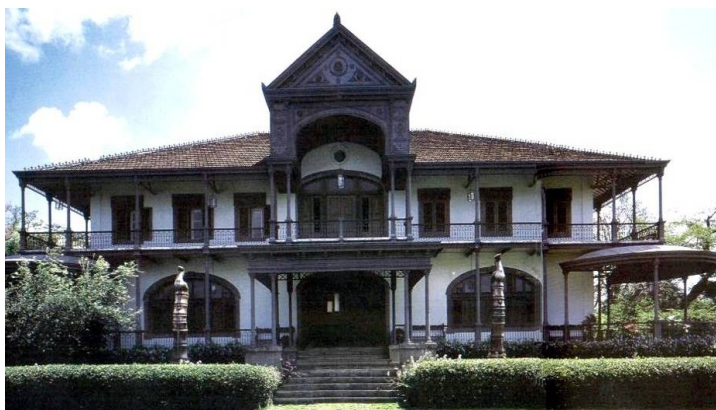
Fotografia 4 – Palacete do Engenho, Recife, PE. Exemplo de residência importada da Bélgica via Nova York (1895), com estrutura de ferro fundido.
