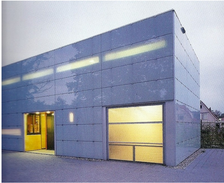
Fotografia 160 – Residência com vedação em painéis de vidro. Local: Almelo, Holanda.
