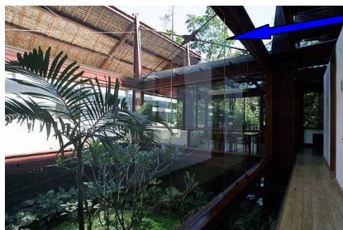
Fotografia 50 – Residência “pouso alto” com barras de aço como tirantes da estrutura.
