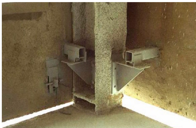
Fotografia 137 - Exemplo de fixação de painel de concreto com os inserts metálicos incorporados.
