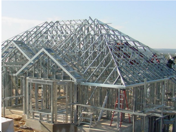
Fotografia 198– Residência sendo construída com o sistema construtivo steel frame .
