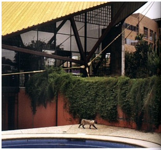
Fotografia 57- Exemplo de residência com utilização de telha em aço trapezoidal.
