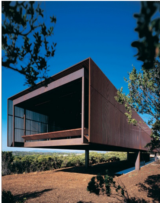
Fotografia 64 -St. Andrews Beach House.
