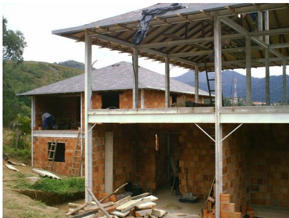
Fotografias 180, 181 e 182 -Execução de telhado em residência com estrutura metálica e cobertura com telhas tipo shingle . Local: Penedo, Itatiaia, RJ.
