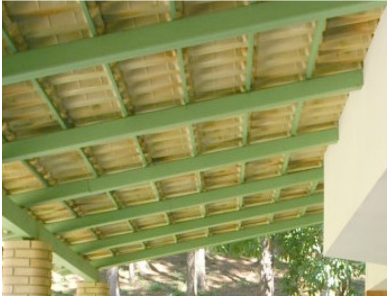
Fotografia 171 - Exemplo de cobertura estruturada em perfis de aço com telhas cerâmicas. Local: Penedo, Itaiaia, RJ
