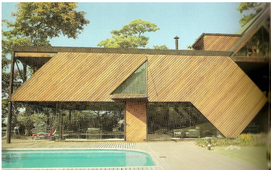
Fotografia 165 - Exemplo residência com estrutura em aço e fechamento em painel de madeira em lambri. Local: Rio de Janeiro, RJ, Brasil.
