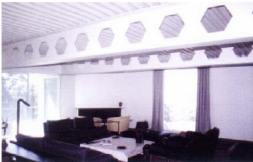
Fotografia 32 – Exemplo de viga alveolar.
