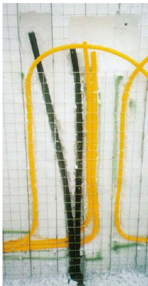
Fotografia 136 - Exemplo de fabricação de painel de concreto com armadura e instalações incorporadas.
