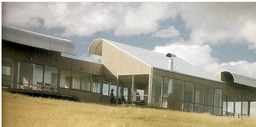
Fotografia 177 – Exemplo de residência com cobertura em aço. Local: Bells Beach, Austrália.
