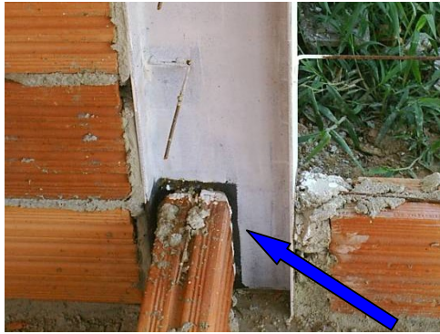
Fotografia 126- Exemplo de detalhe de ligação pilar /alvenaria, onde sobra um espaço vazio a ser preenchido com revestimento.
