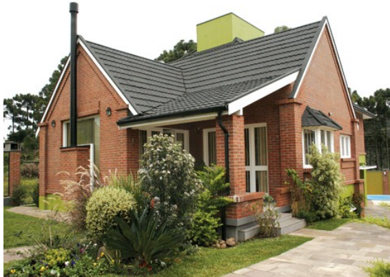
Fotografia 60 - Exemplo de residência com telha em aço gravilhada.
