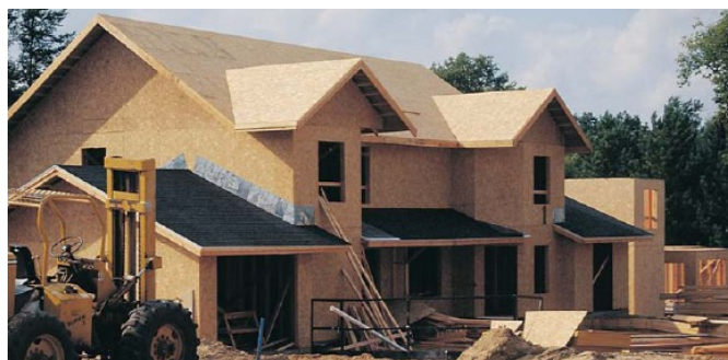
Fotografia 115 - Exemplo de utilização de painel “OSB” em residência. Este tipo de painel pode ser usado tanto em lajes como em outras vedações.
