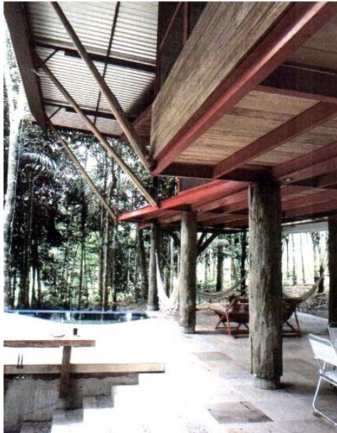
Fotografia 19- Exemplo de utilização de perfil "I" em uma residência com mistura de materiais diferenciados, como: pilares em madeira, vigas em aço, piso em madeira e paredes internas em "dry wall".
