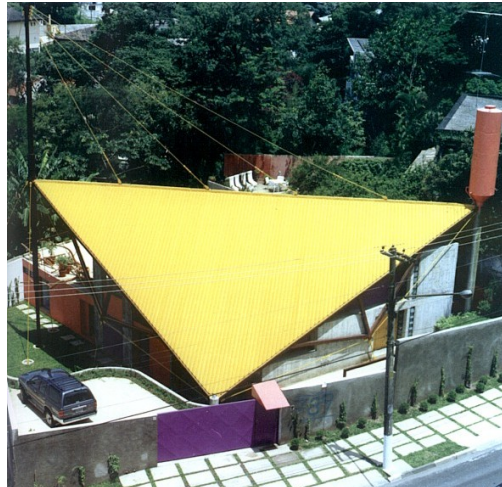
Fotografia 58- Exemplo de residência com utilização de telha em aço trapezoidal.
