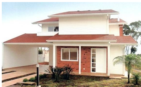
Fotografia 12 - Exemplo de uma residência feita com sistema construtivo Light Steel Frame . Projeto: Luciano Setim Freitas. Local: Curitiba, PR.
