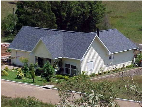
Fotografia 151 – Exemplo de residência executada com painel metálico, sistema QUICK HOUSE .
