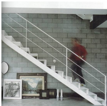
Fotografia 42- Degraus de escada em chapa xadrez em uma residência.
