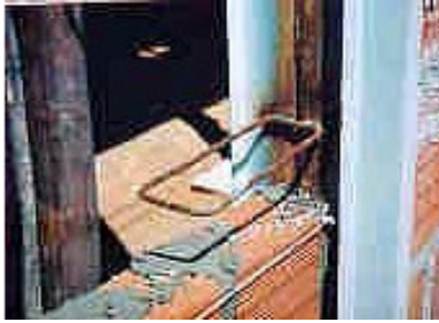
Fotografia 122 - Ligação de pilar e alvenaria com ferro dobrado de amarração .
