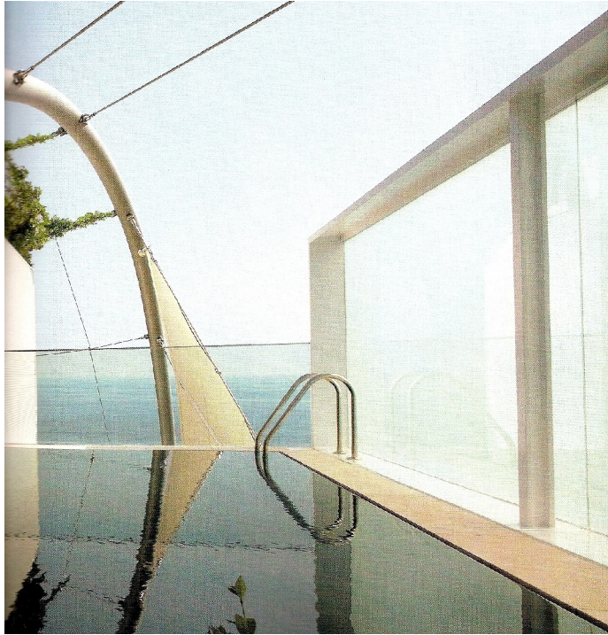
Fotografia 27- Detalhe da estrutura tubular redonda formando arcos que suportam uma cobertura de membrana tensionada.
