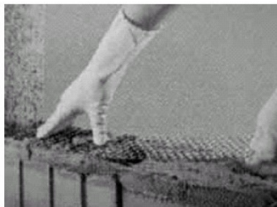
Fotografia 119- Ligação de pilar e alvenaria com tela soldada. Este tipo de ligação forma uma ligação vinculada semi- rígida entre alvenaria e pilar.
