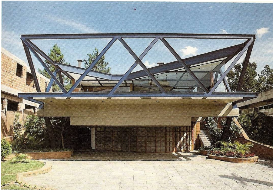
Fotografia 37 – Residência caracterizada por um pórtico formado a partir de uma treliça. Este tipo de solução arquitetônica mais é uma reverência à estrutura metálica do que uma solução estrutural necessária.
