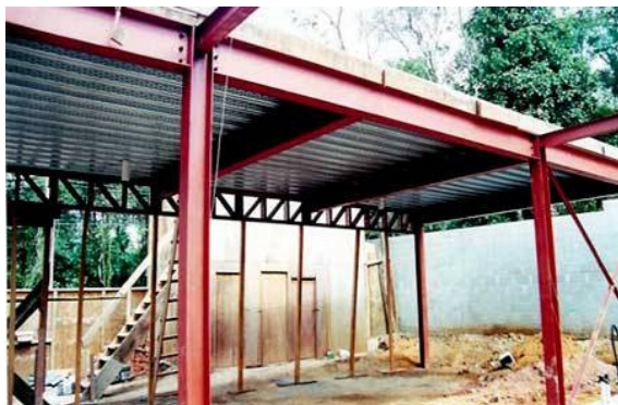
Fotografia 113 - Utilização de laje steel deck em obra residencial.
