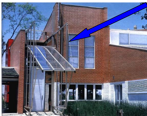
Fotografia 52- Cabos de aço como tirantes em cobertura de uma residência.
