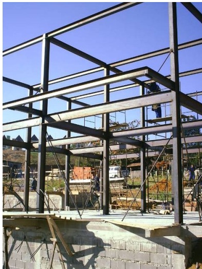
Fotografia 11 - Obra residencial em Penedo realizada com perfis laminados da Gerdau.
